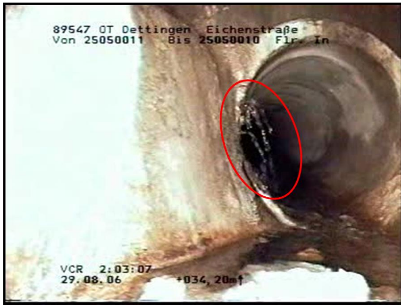
undichte Schachteinbindung SK 1, FW I
