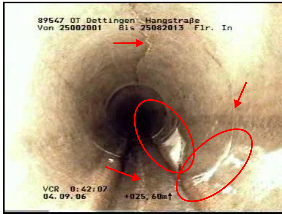
Rissbildung und Kalkablagerung SK 1, FW I
