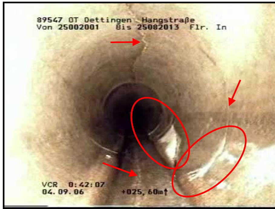
Rissbildung und Kalkablagerung SK 1, FW I
