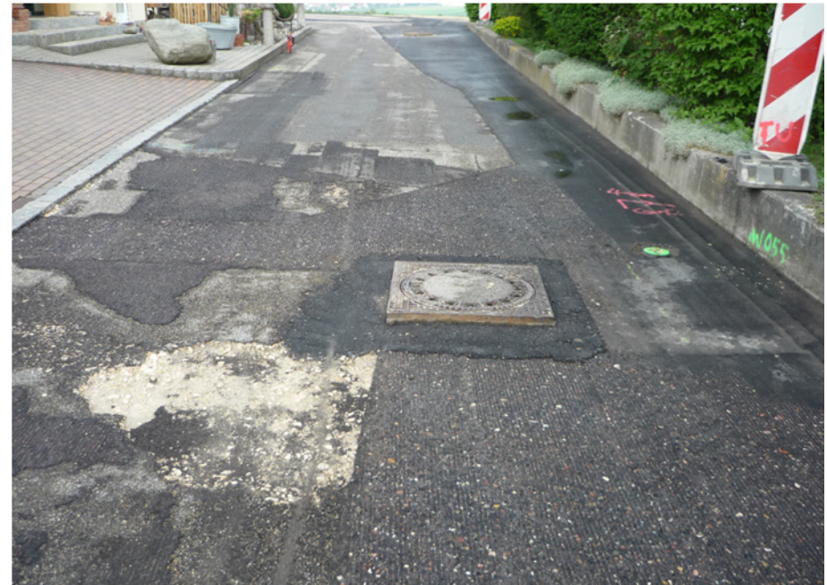
Teilsanierung durch Belagserneuerung
