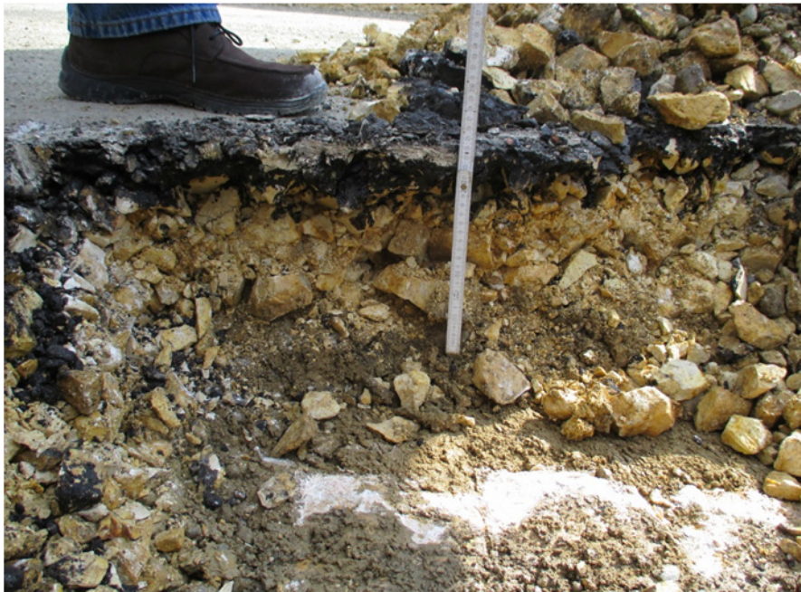
Prüfung des Fahrbahnaufbaus
